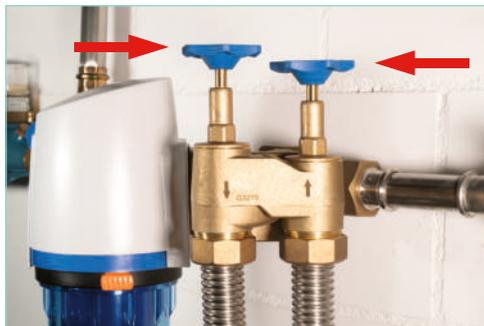
Wenn Sie den Bypass schliessen müssen, drehen Sie beide Hähne komplett zu. Sie werden ca. nach der Hälfte einen Widerstand spüren. Es ist wichtig, dort weiterzudrehen. Dies müssen Sie z. B. tun, wenn die Anlage Wasser verliert.
